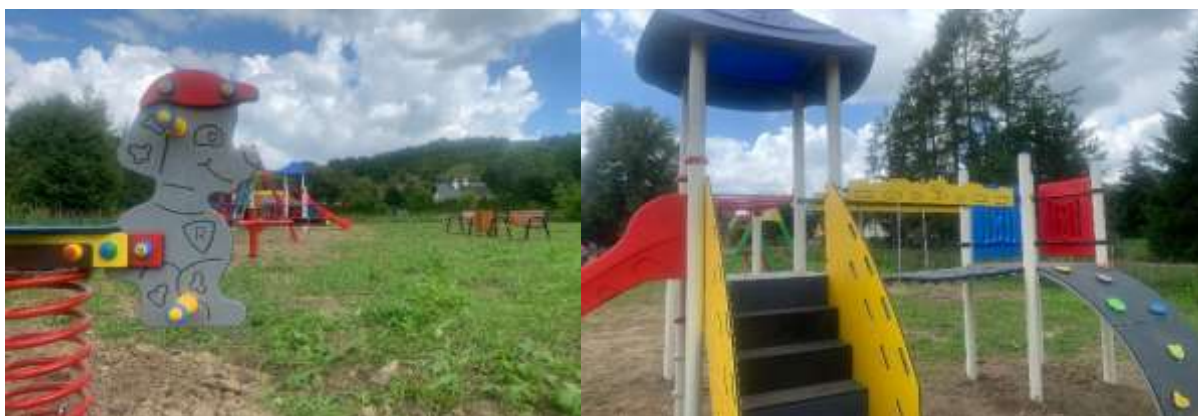
Budowa placu zabaw w miejscowości Nowy Borek - Przylasek.
