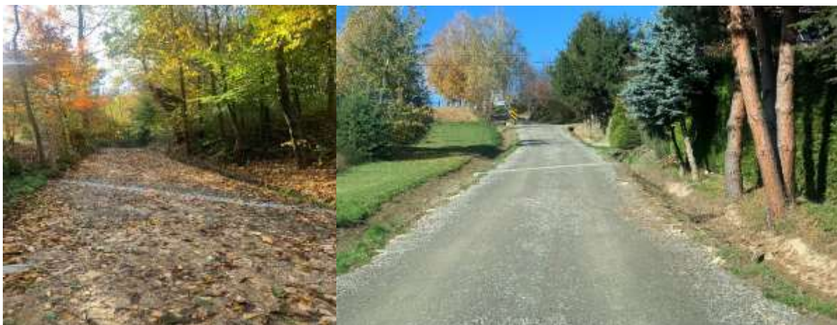
Przebudowa dróg dojazdowych do gruntów rolnych na obiekcie posceniowym w obrębach: Piątkowa dz. 2612/1, Futoma dz. 107/1.
