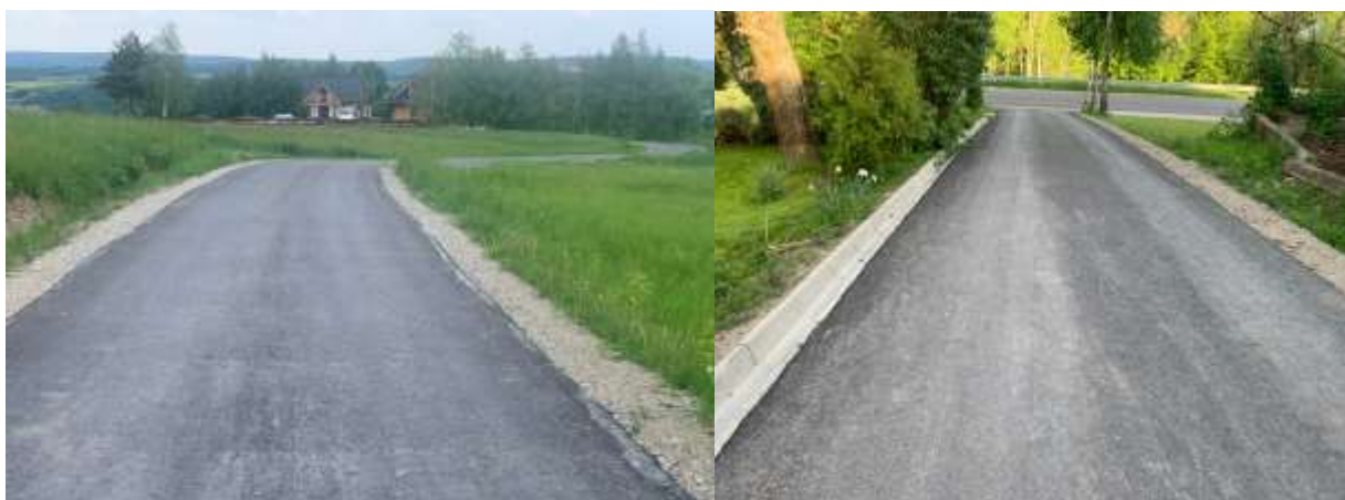
Przebudowa dróg gminnych w Białce nr 600/1 i w Błazowej Górnej droga nr 760.
