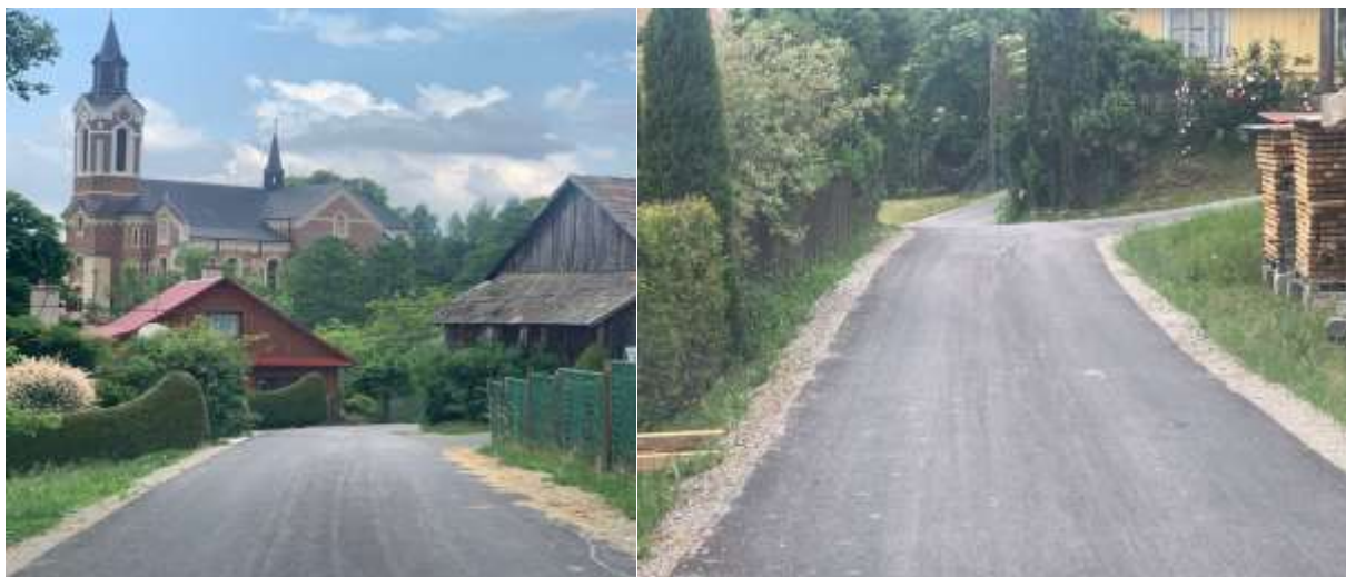
Przebudowa dróg gminnych nr 2835 i 2802 w Futomie.
