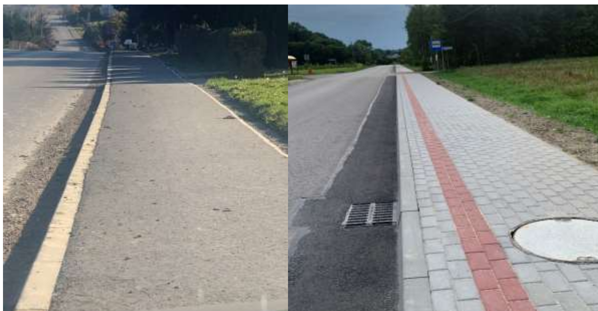
Nowa infrastruktura chodnikowa powstała: w Nowym Borku 1500 m w nawierzchni asfaltowej oraz Lecce 230 metrów w nawierzchni brukowej.
