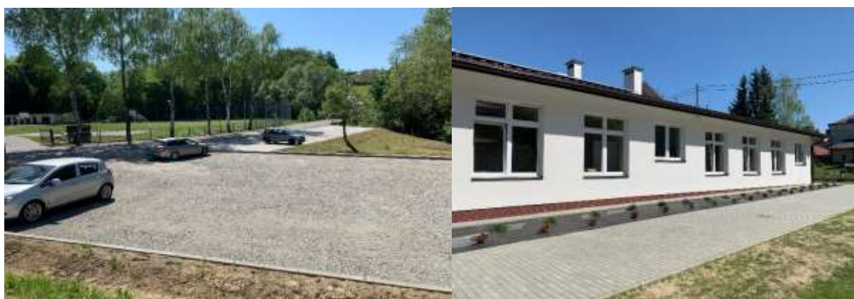
Rozbudowa Szkoły Podstawowej w Futomie - etap II. Parking przy Szkole Podstawowej w Futomie
