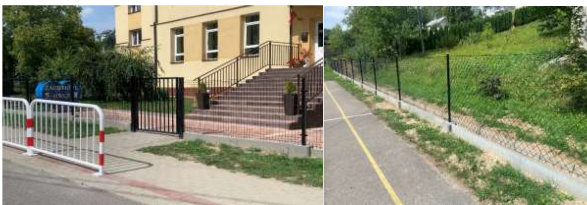
Ogrodzenie przy Szkole Podstawowej w Lecce łącznie z odwodnieniem.
