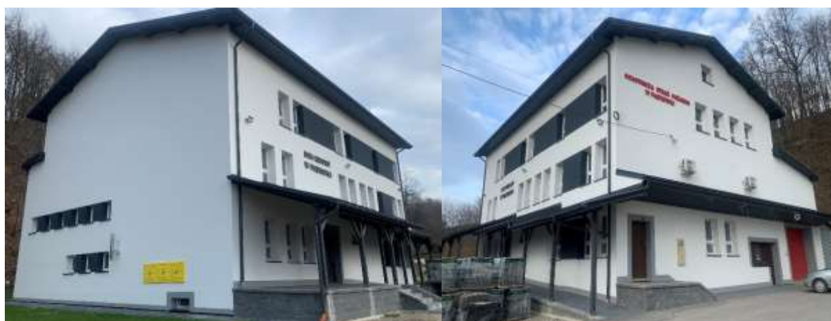
Termomodernizacja Domu Ludowego w Piątkowej.
