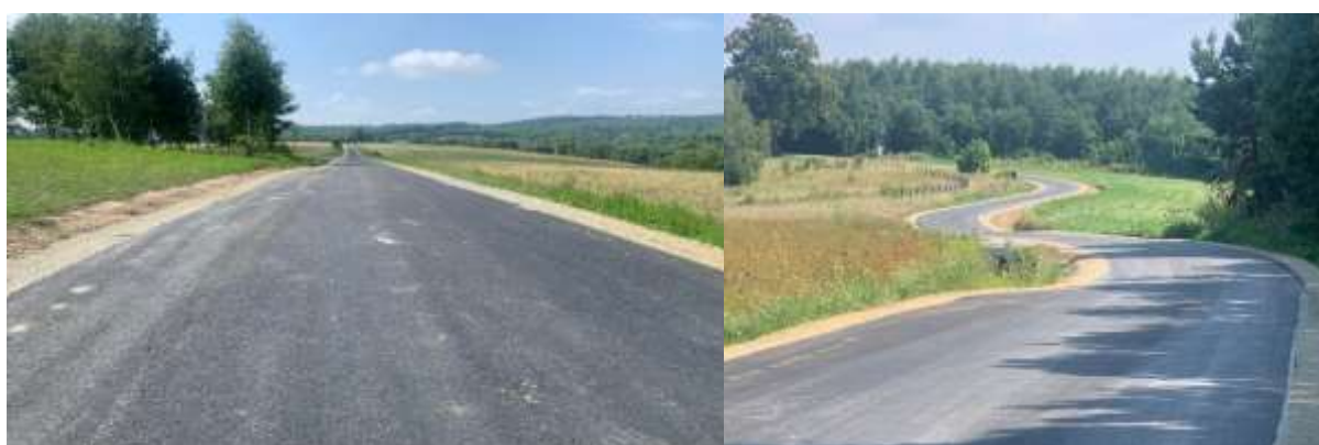
Przebudowa drogi gminnej Nr 108060R Błażowa Dolna – Wola Błażowska w km od 2+220 do 3+210 w miejscowości Błażowa Dolna.
