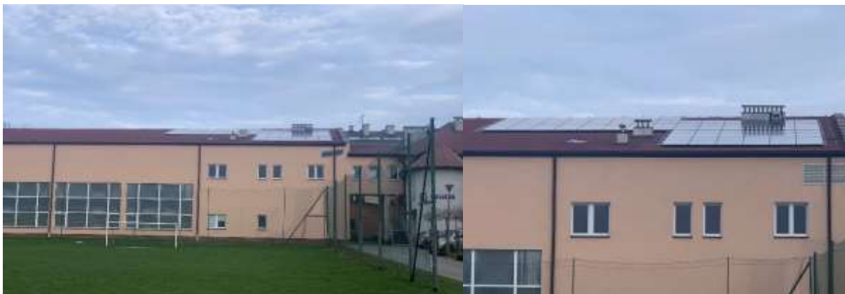
Budowa instalacji fotowoltaicznej na Hali Sportowej w Błaszów.
